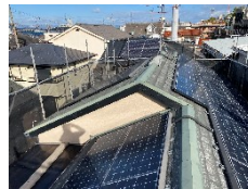
太陽光パネルが設置されているのでその箇所以外の屋根を塗装しました。
