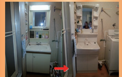
洗面台の取替えです。
