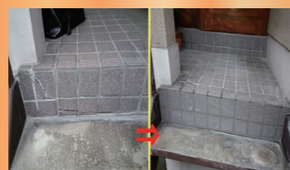
玄関ポーチ立ち上りのタイルのひび割れ補修です。タイルを貼り替えました。
