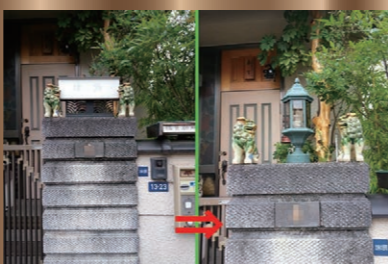
LED門柱灯の取替えです。
