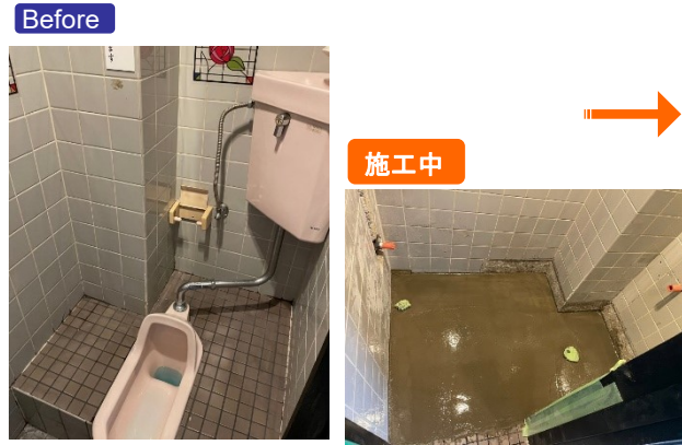
◆大東市 R様 店舗トイレ改修工事 (和式トイレから洋式トイレ)
