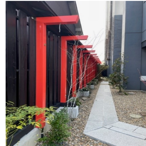
◆奈良市 某ホテル外灯工事 オーデリック照明器具使用
