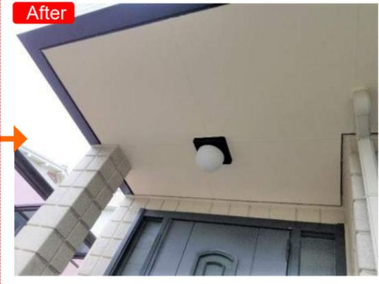
下地処理、下塗り、上塗り2回で完了。剥がれていた箇所は一部でしたが、ベランダ下軒天を全面塗装しました。
